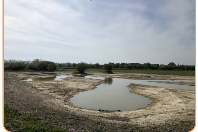
Zone humide de Birieux après travaux - Source : SRDCBS
