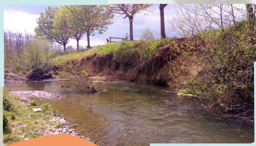
JUILLET Travaux au camping de St Didier/Chal p.21
